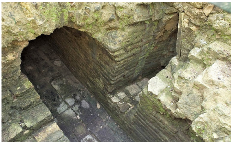
Figura 4.33. Encuentro de dos cloacas en el cruce de calles (Archivo CAI)
