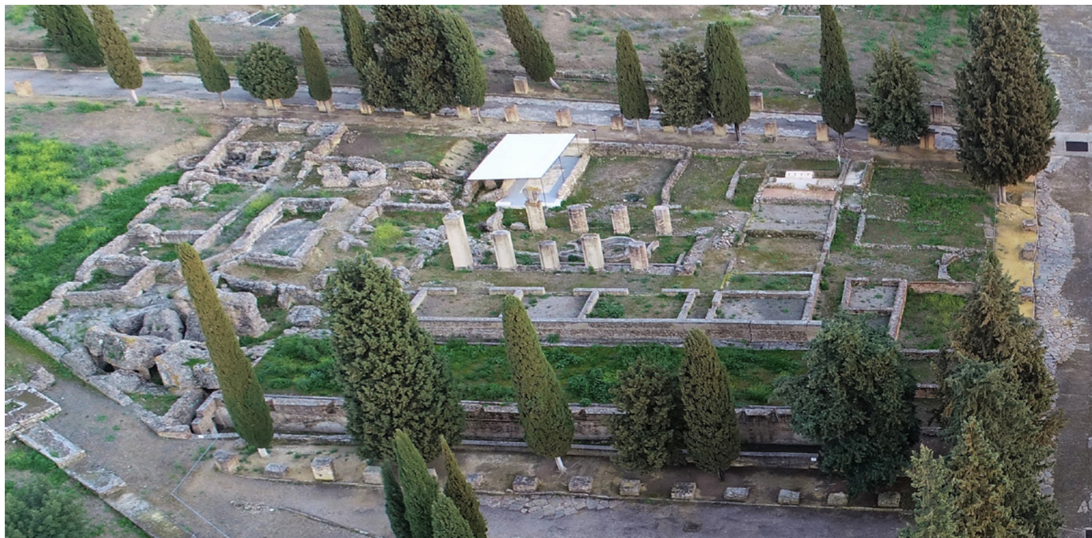
Figura 4.26. Casa de la Exedra, inmueble consolidado en buen estado general de conservación con patologías puntuales
