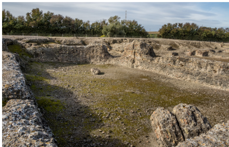
Figura 2.10. Muros de opus testaceum con núcleo de opus caementicium en las Termas Mayores
