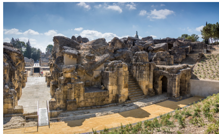
Figura 2.14. Fábrica de sillares de la fachada occidental del anfiteatro
