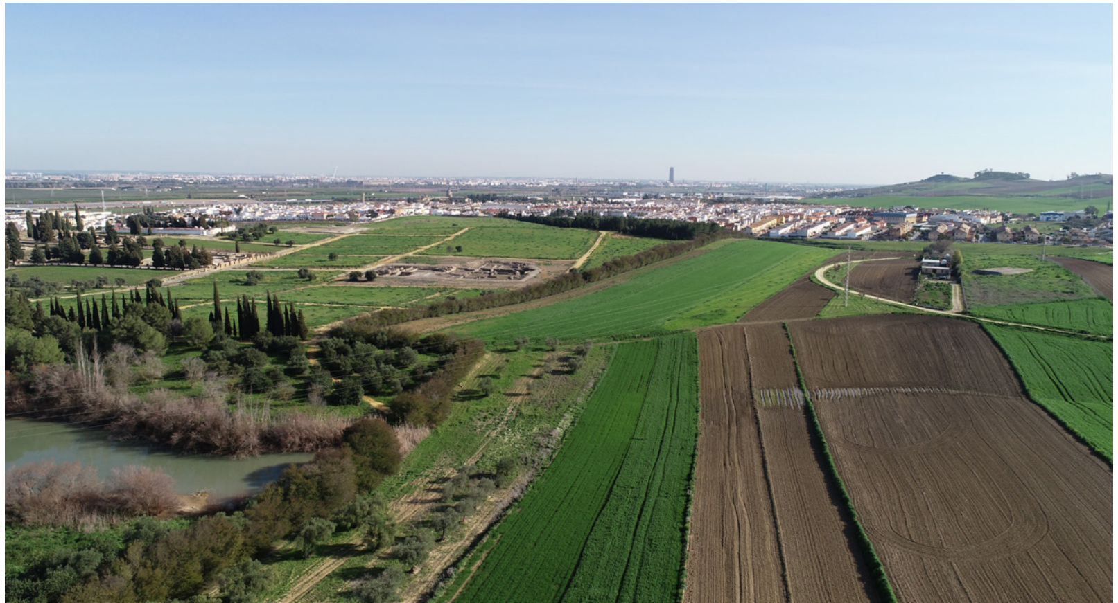
Figura 2.8. El sector occidental de la ampliación adrianea de Itálica no llegó a urbanizarse. Esta zona, comprendida entre las Termas Mayores y el castellum aquae –estructura plana en el extremo derecho de la imagen–, es en la actualidad un espacio de parcelas rústicas
