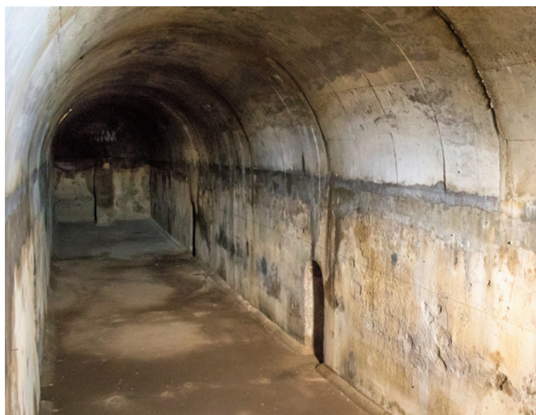
Figura 4.35. Vista aérea (arriba) e interior del castellum aquae , protegido con bóvedas de hormigón en la década de 1970
