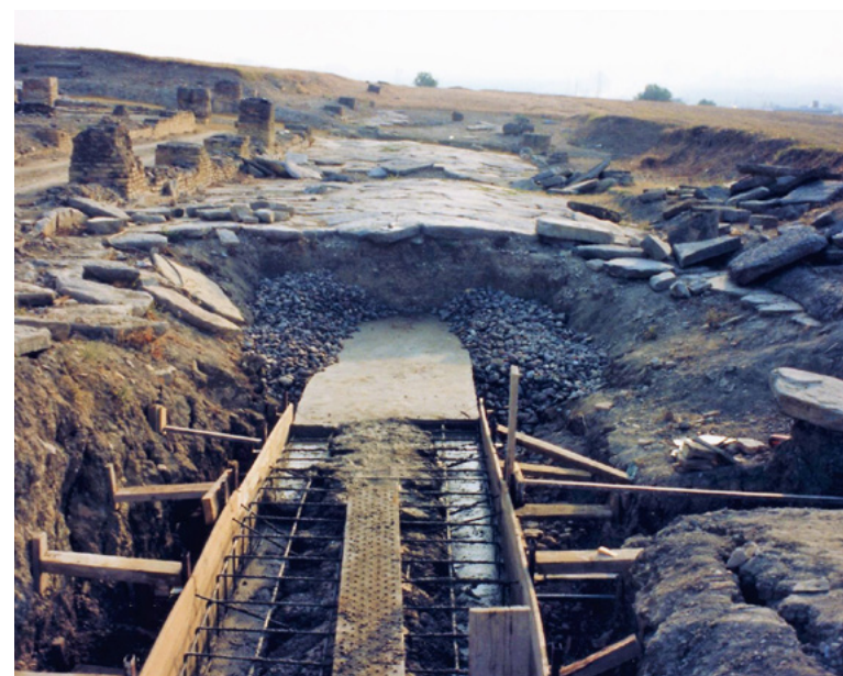
Figura 4.14. Antiguas obras de restauración del viario y de las cloacas de Itálica (Archivo CAI)
