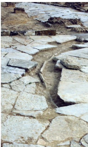
Figura 2.157. Trabajos de conservación del viario del entorno de la Casa de la Cañada Honda. Actuación en la cloaca del cardo oriental (derecha) y hallazgo de una fistula aquaria bajo las losas de la calzada (Archivo CAI)
