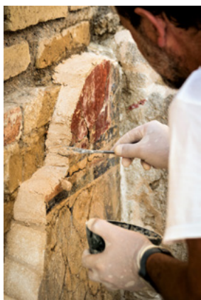
Figura 4.45. Trabajos de restauración de revestimientos parietales en la Casa de la Exedra
