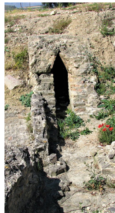
Figura II.50. Sección de una cloaca bajo el tetrapylon siguiendo la dirección de los decumani A.1.1-B.1.1.
