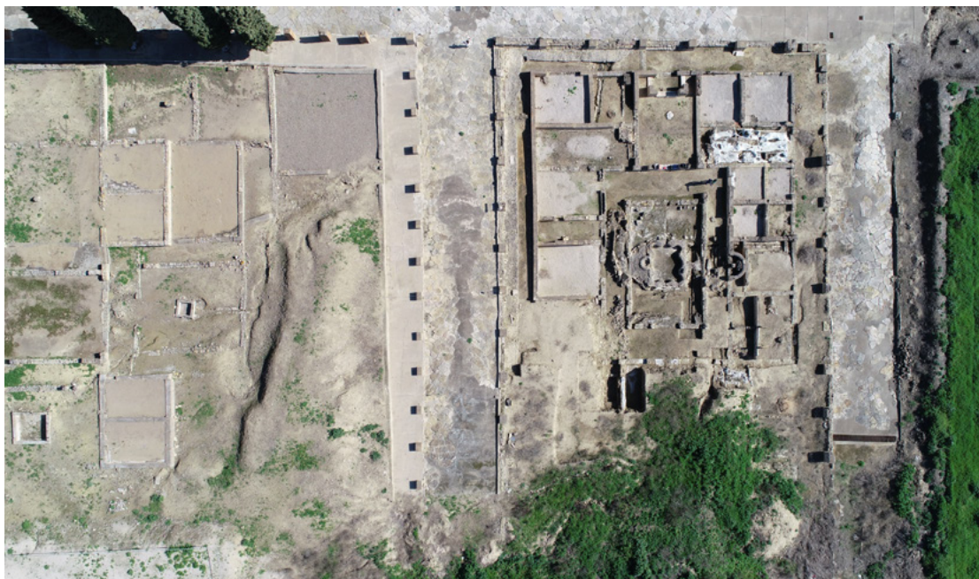
Figura 4.20. Vista de las Casas de Hylas (izquierda) y de Cañada Honda, situadas en un emplazamiento desfavorable para la conservación por la acción del agua
