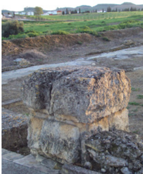
Figura 2.38. Pilar de sillares almohadillados en la manzana de la Casa de la Cañada Honda
