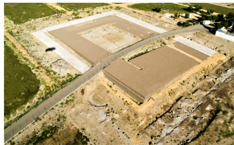
Figura 4.28. Fachada este del Traianeum tras la consolidación realizada en 2006
