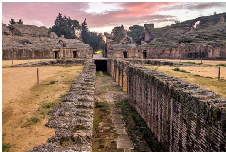
Figura 4.36. Vistas del anfiteatro, inmueble con un alto nivel de integridad (IAPH)
