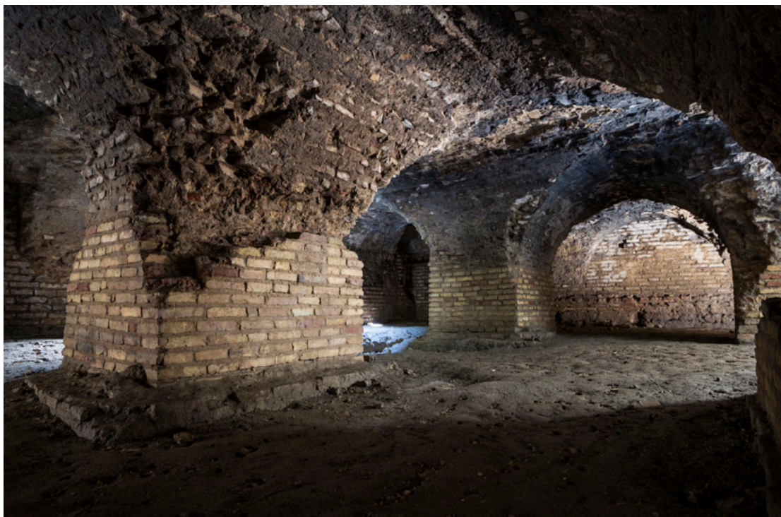
Figura 2.53. Criptopórtico de las Termas Mayores
