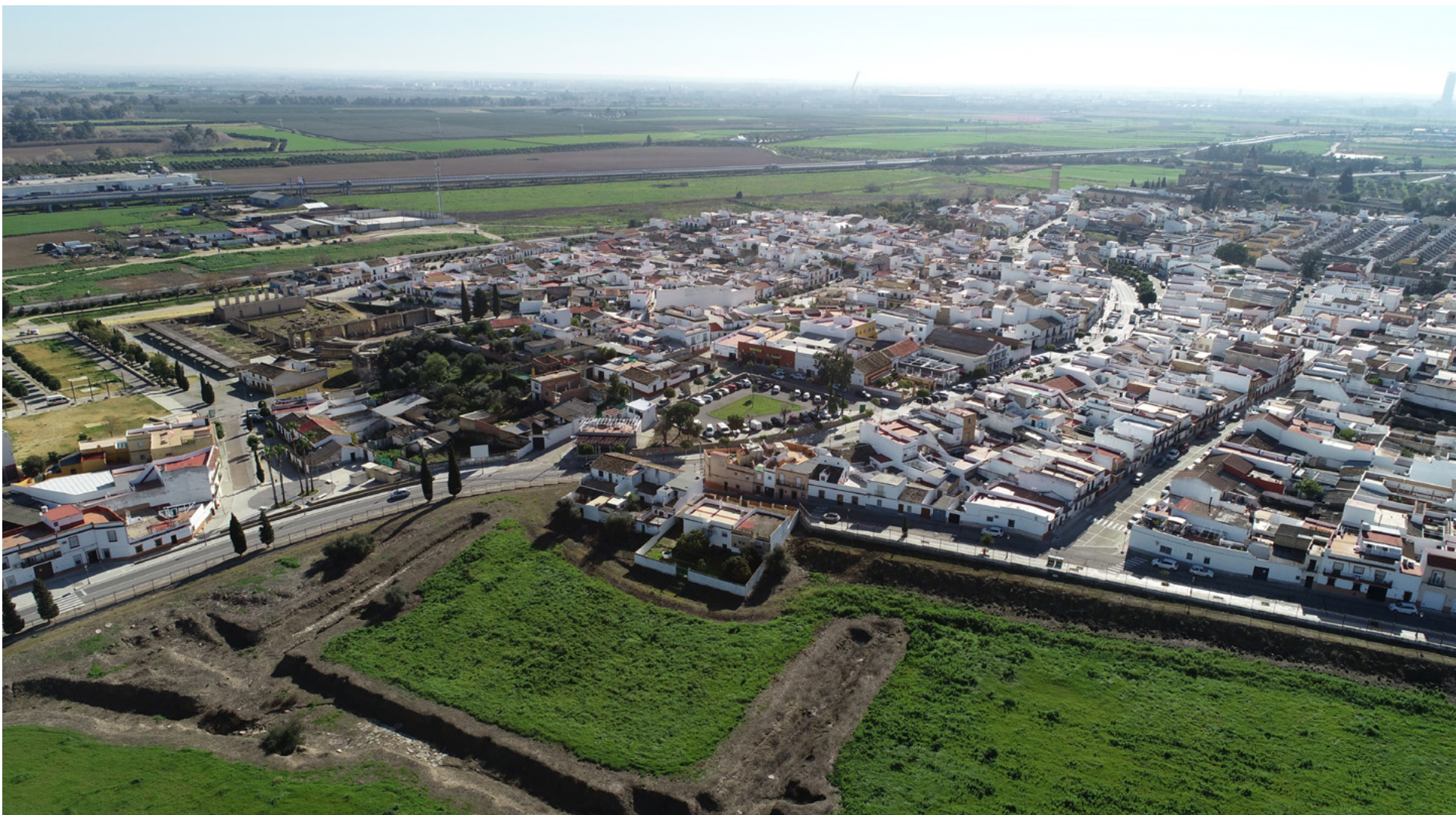
Figura 2.101. Sector sureste de la zona de amortiguamiento. Esta parte coincide con un ámbito del casco urbano de Santiponce en el que se localiza un espacio fundamental de la ciudad de Itálica, como el teatro
