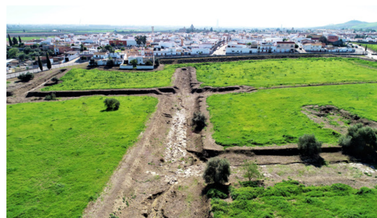
Figura 4.21. Zona de Cañada Honda parcialmente excavada en la que se han producido colapsos en las calles y cloacas debido al arrastre de agua
