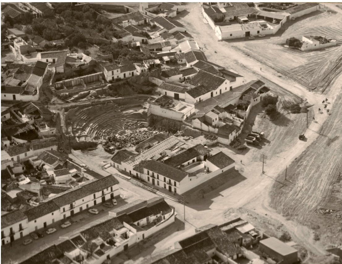
Figura 2.155. Excavaciones en el teatro (año 1972) (Archivo CAI)
