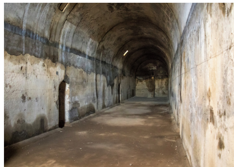
Figura II.48. Interior de una de las naves del castellum aquae
