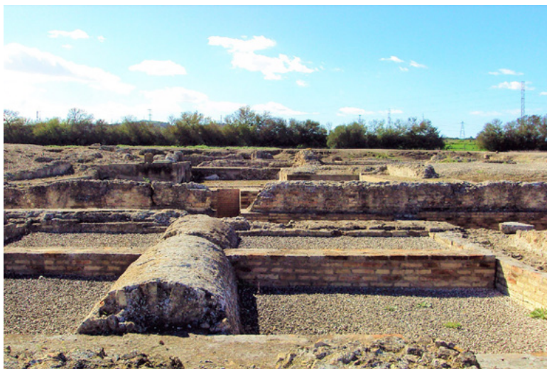
Figura 4.30. Estructuras subterráneas exhumadas (izquierda) e interior del criptopórtico de las Termas Mayores
